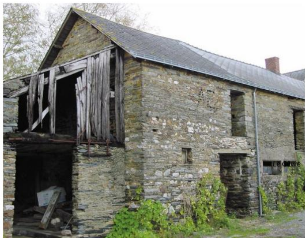
Le corps de ferme avant travaux
