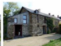
Le corps de ferme après travaux. © L'Atelier Beaufort-Claudes, architectes
