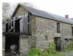
Le corps de ferme avant travaux
